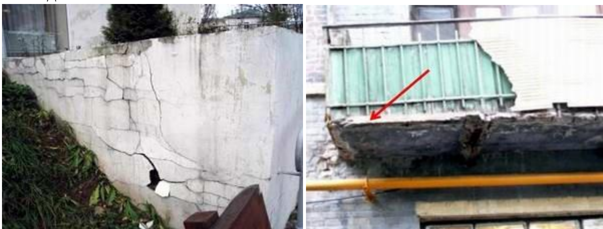
Рис. 1.2. Визуальный осмотр стен и фасадов зданий
