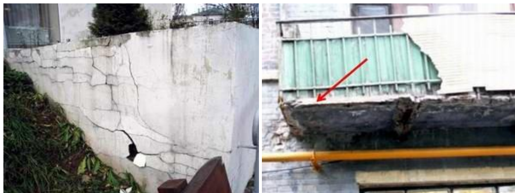
Рис. 1.2. Визуальный осмотр стен и фасадов зданий
