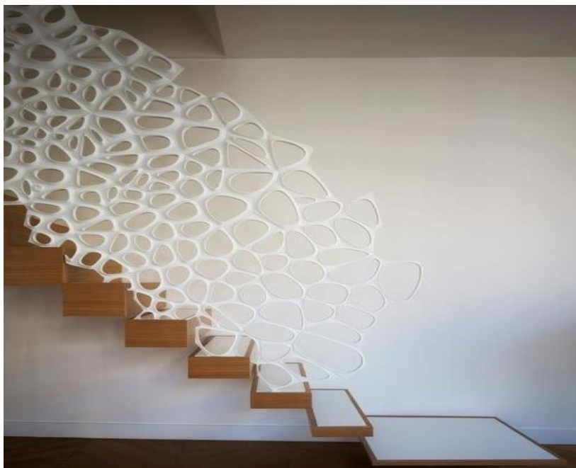
Рисунок 3 – Лестничное ограждение, сделанное 3D принтером [3]
