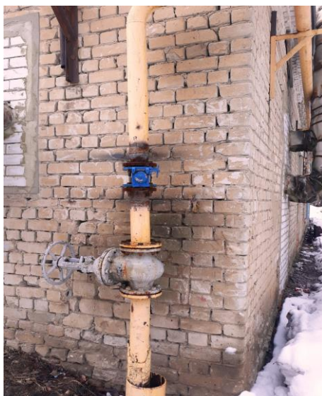
Рисунок 1 – Установленное на газопровод котельной УОРГ 100
