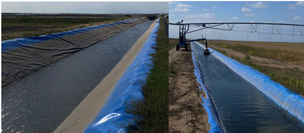
Рисунок 2 - Оросительный канал с покрытием, выполненный из геомембраны LLDPE, Приволжский район, Самарская область
