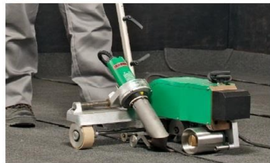
2. Сварка швов с помощью автоматического оборудования
