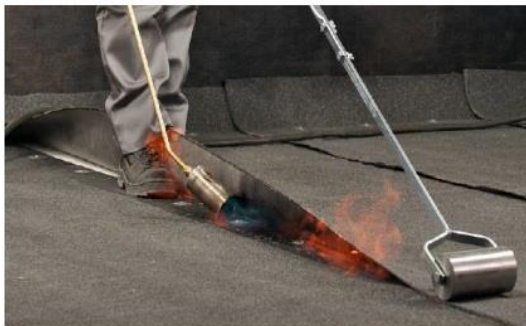
1. Сварка швов при помощи горелки
