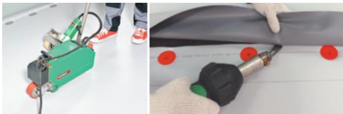
Рисунок 10 – Сварка полотен мембраны [8]
