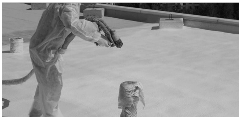
Рисунок 2 – Напыление ППУ на плоскую кровлю здания
