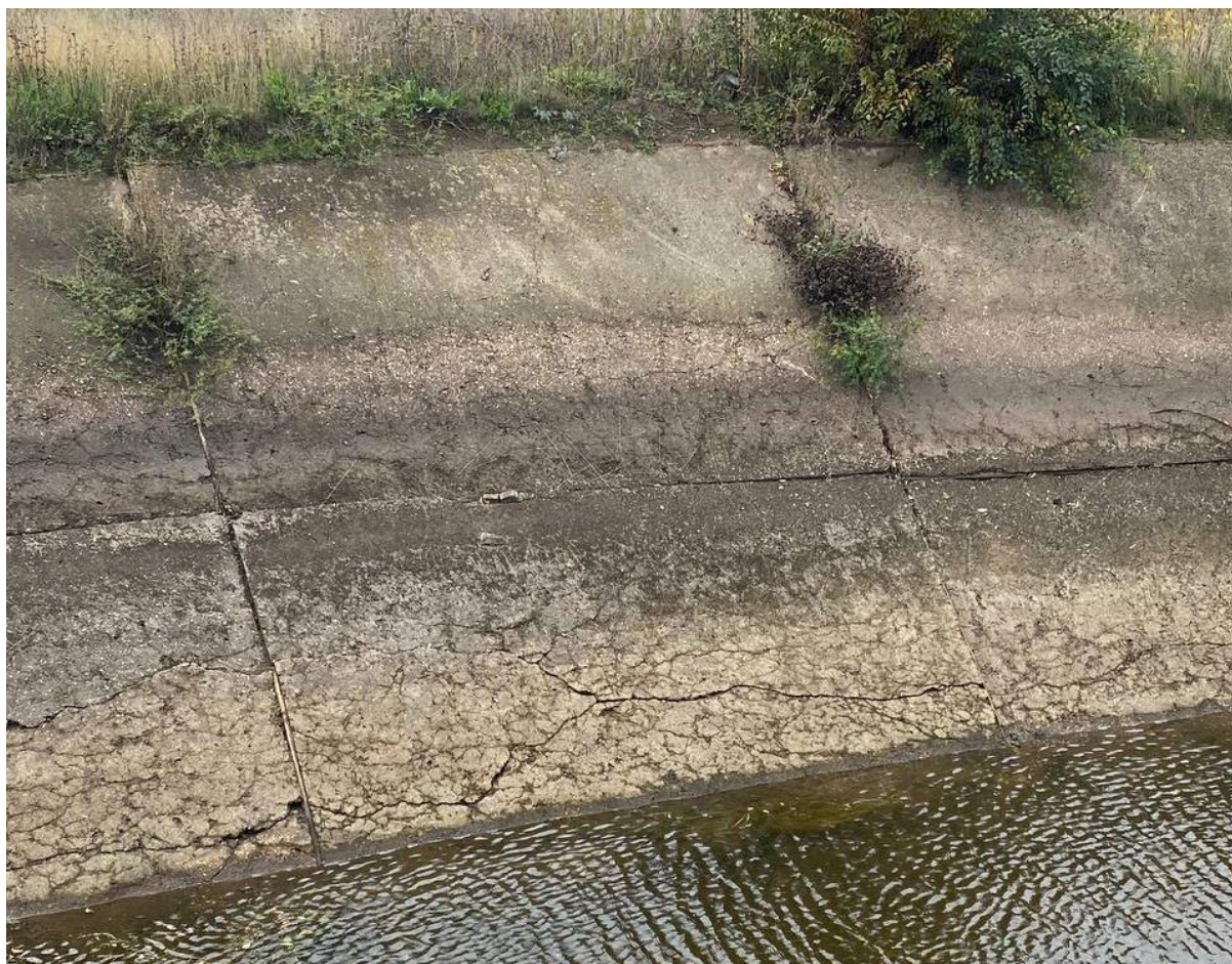
Рисунок 2. Распространение растительности на противофильтрационной облицовке канала
