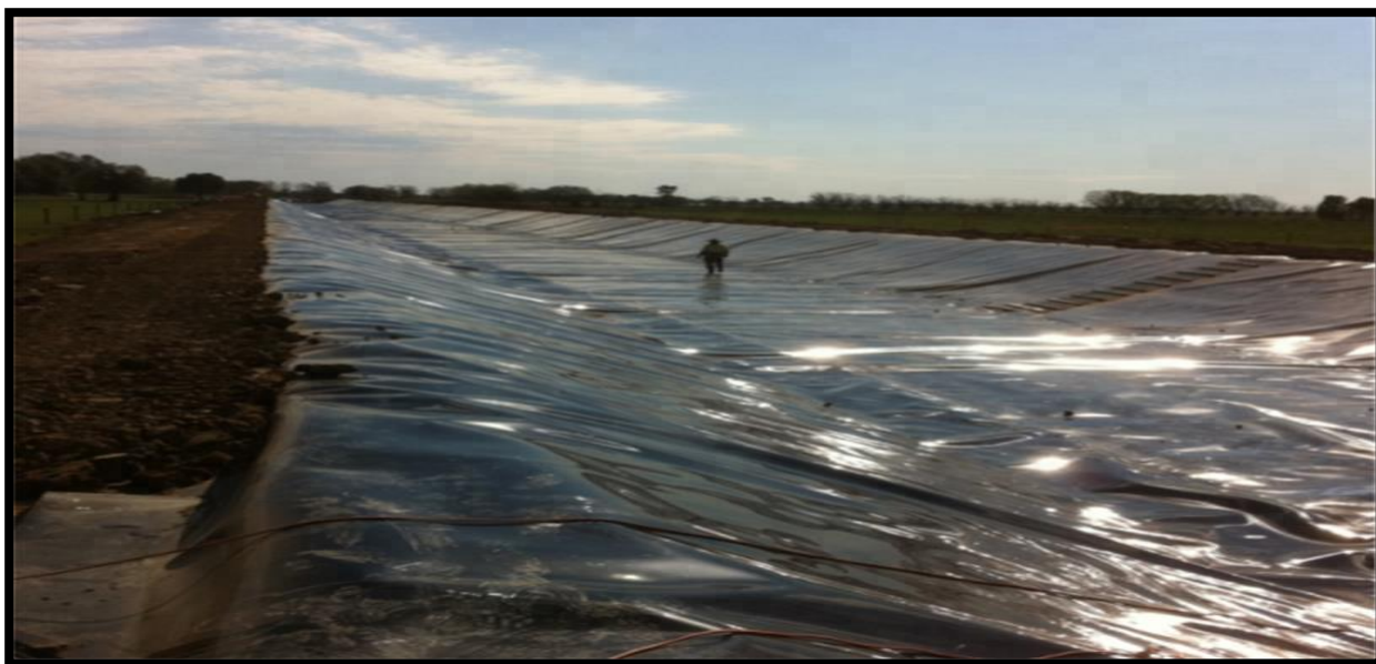
Рисунок 3. Облицованный геосинтетической мембраной оросительный канал
