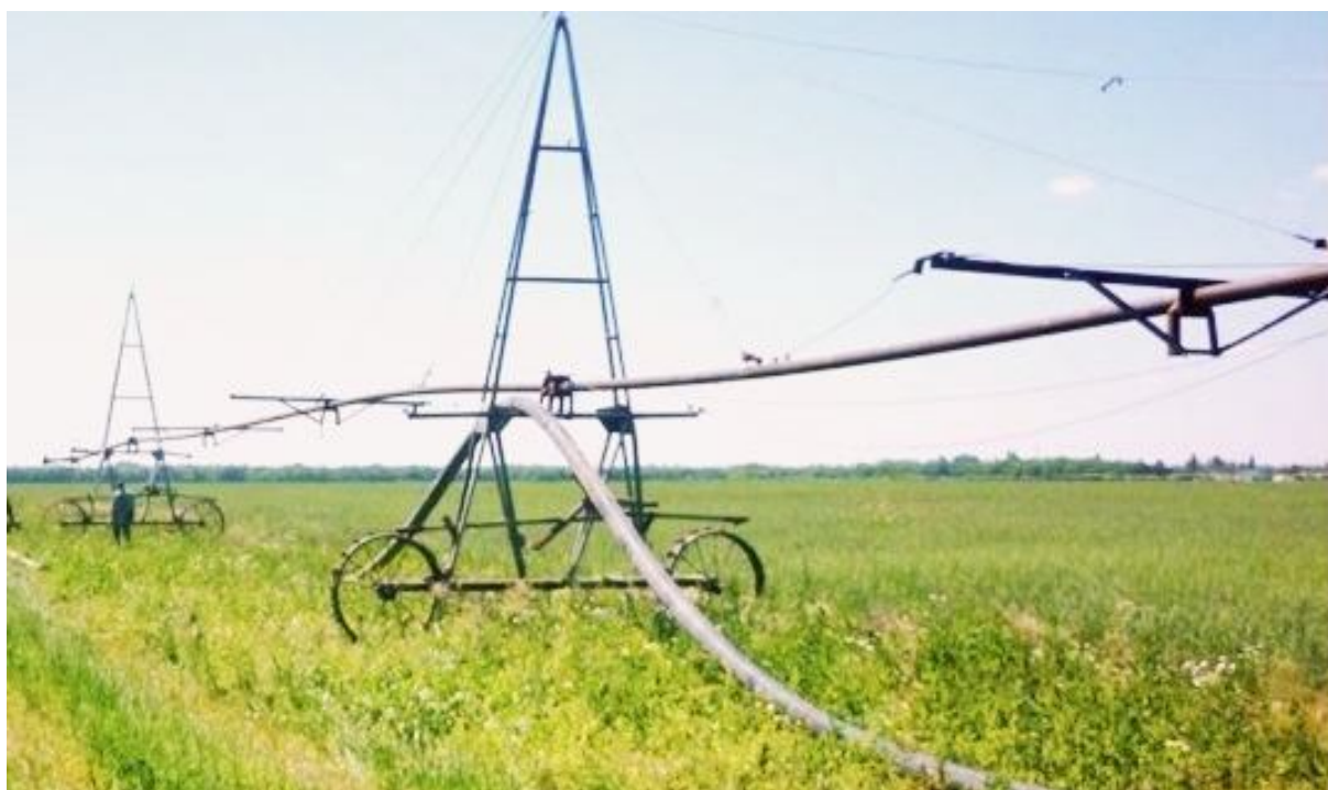
Рисунок 4.7 - Монтаж полиэтиленового водопроводящего трубопровода
