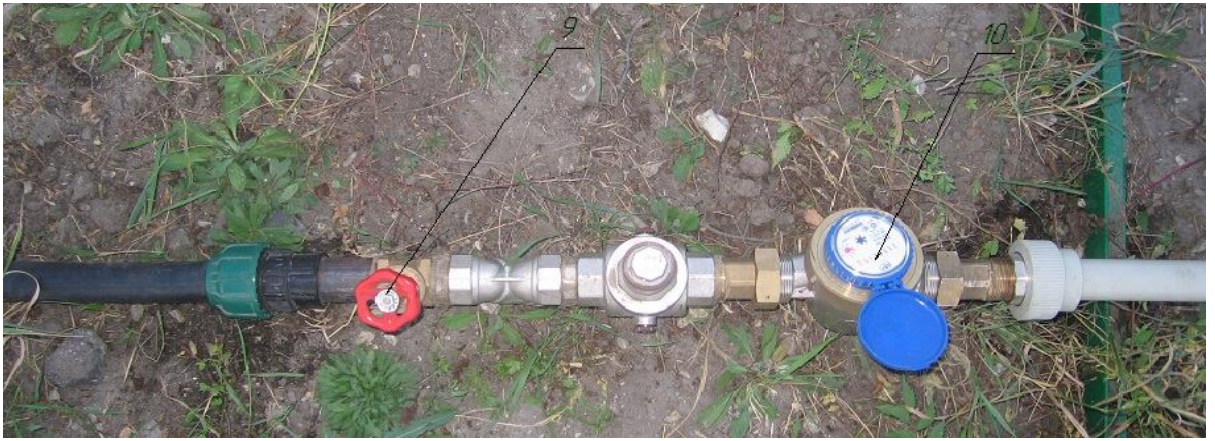
Рисунок 3.6 Запорный кран с водомером
